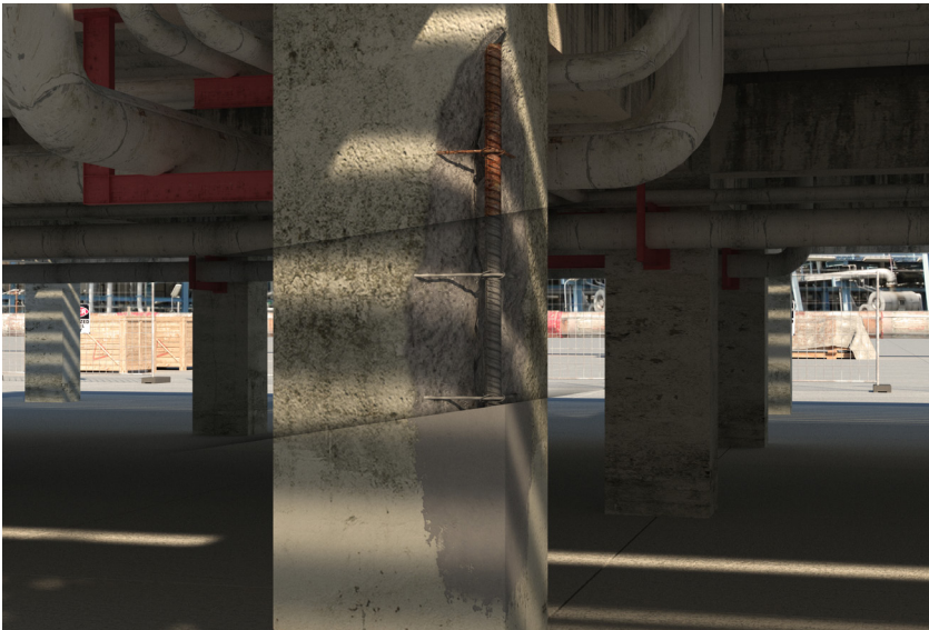
Reparación estructural de una columna de concreto con Fester CM-202
