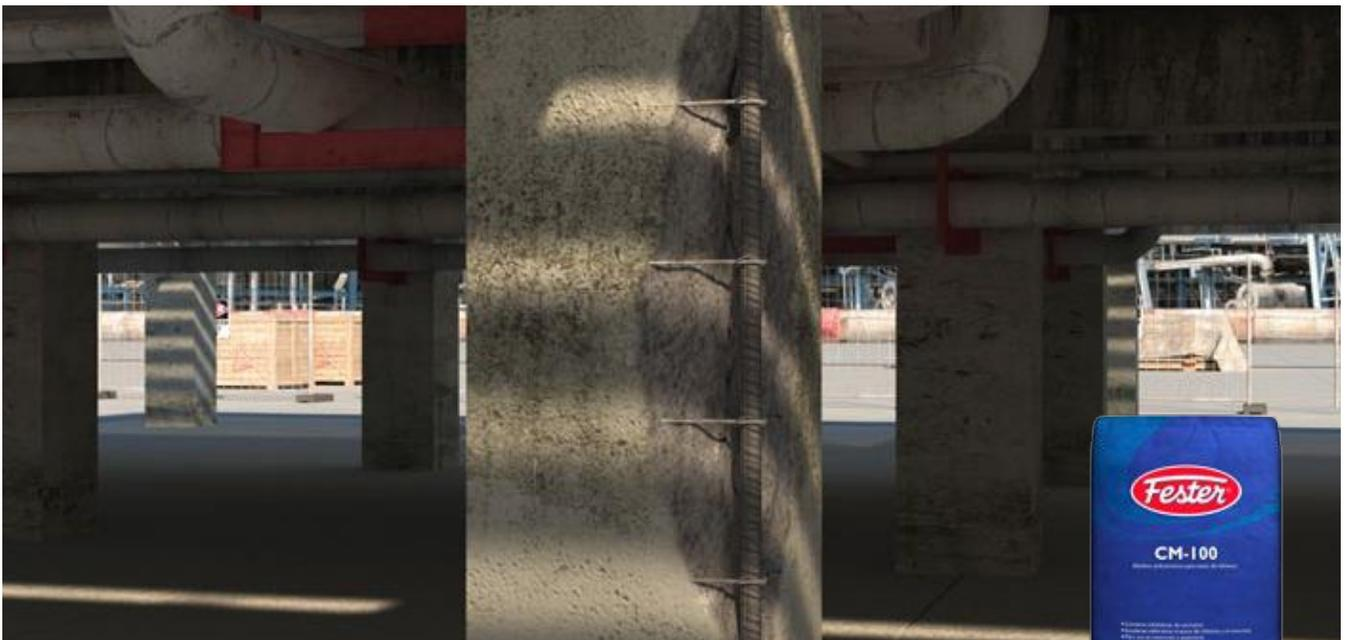
Es muy importante retirar el concreto dañado hasta llegar a concreto sano. Si el acero de refuerzo presenta corrosión es necesario descubrir toda la varilla, tanto la parte ciega como la parte frontal y aplicar **Fester CM-100** previo a la aplicación del mortero reparador.
