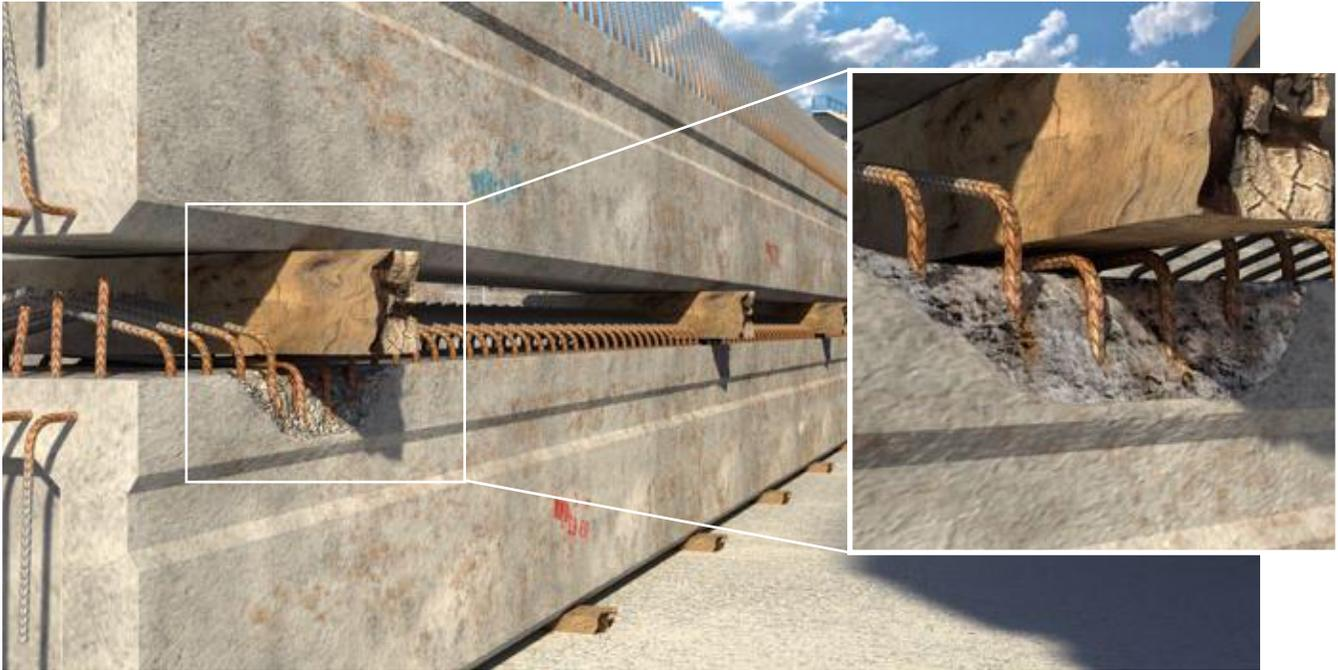
Por sus capacidades estructurales **Fester CM-201** y **Fester CM-202** son una excelente opción para reparar elementos de concreto prefabricado, además su rápido fraguado permite liberar los elementos en menos de 60 min una vez aplicado el producto.
